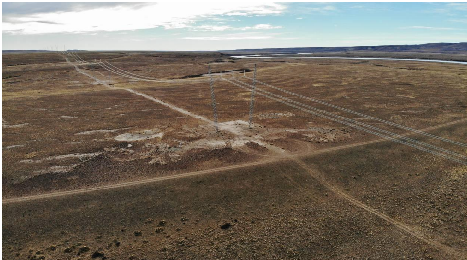
Fotografía 81. Línea Eléctrica existente. Niveles de terrazas del río Santa Cruz. Coord. 50° 07' 48''S, 69° 12' 46''O. Vista hacia el NE).
