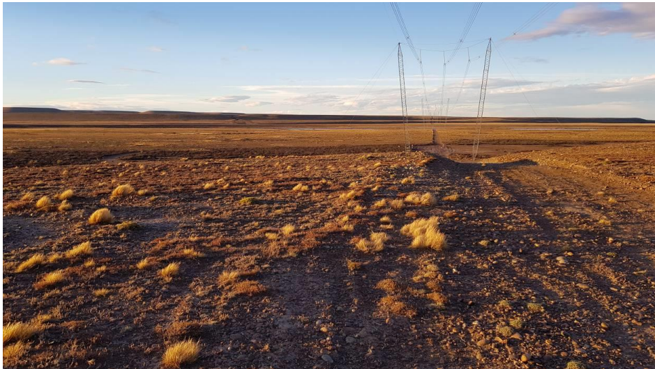
Fotografía 92. Niveles de terrazas del río Santa Cruz (Coord. 50° 11' 27" S; 69° 18' 34" O, vista al NE).
