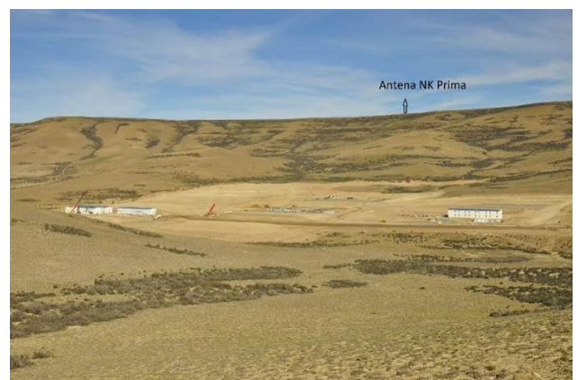
Fotografía 15. Ubicación Antena CCL Prima y torre del vértice CL4. Tomada por: Andreone, R.
